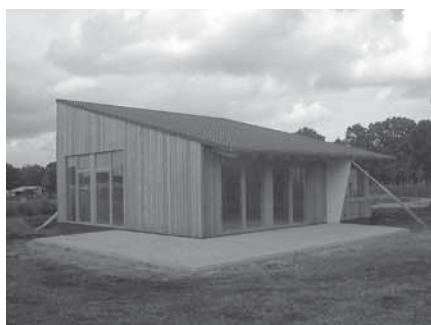
Das neue Vereinshaus der Kleingartenanlage ist bald fertig
